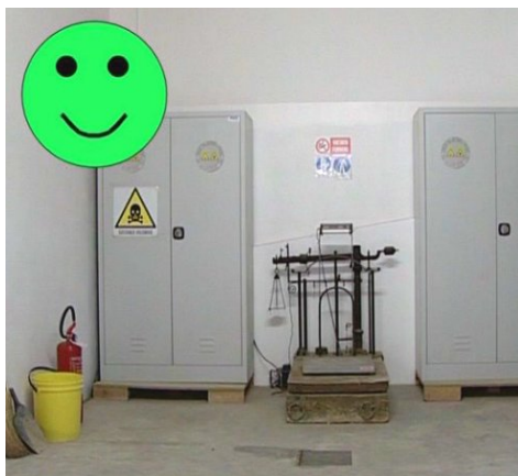
Fig. 13 – Magazzino con armadi specifici per lo stoccaggio degli agrofarmaci.
