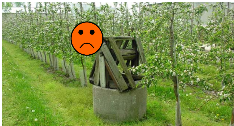
Fig. 73 – Pozzo non adeguatamente protetto (Foto ISK)
